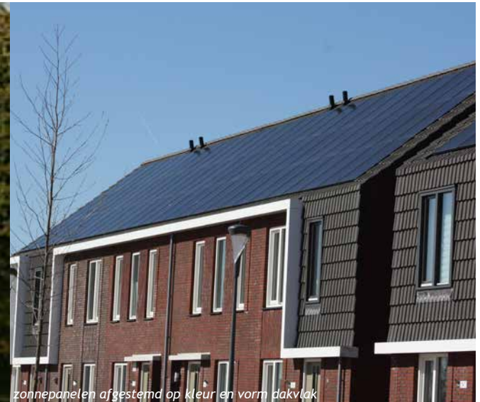
zonnepanelen afgestemd op kleur en vorm dakvlak
