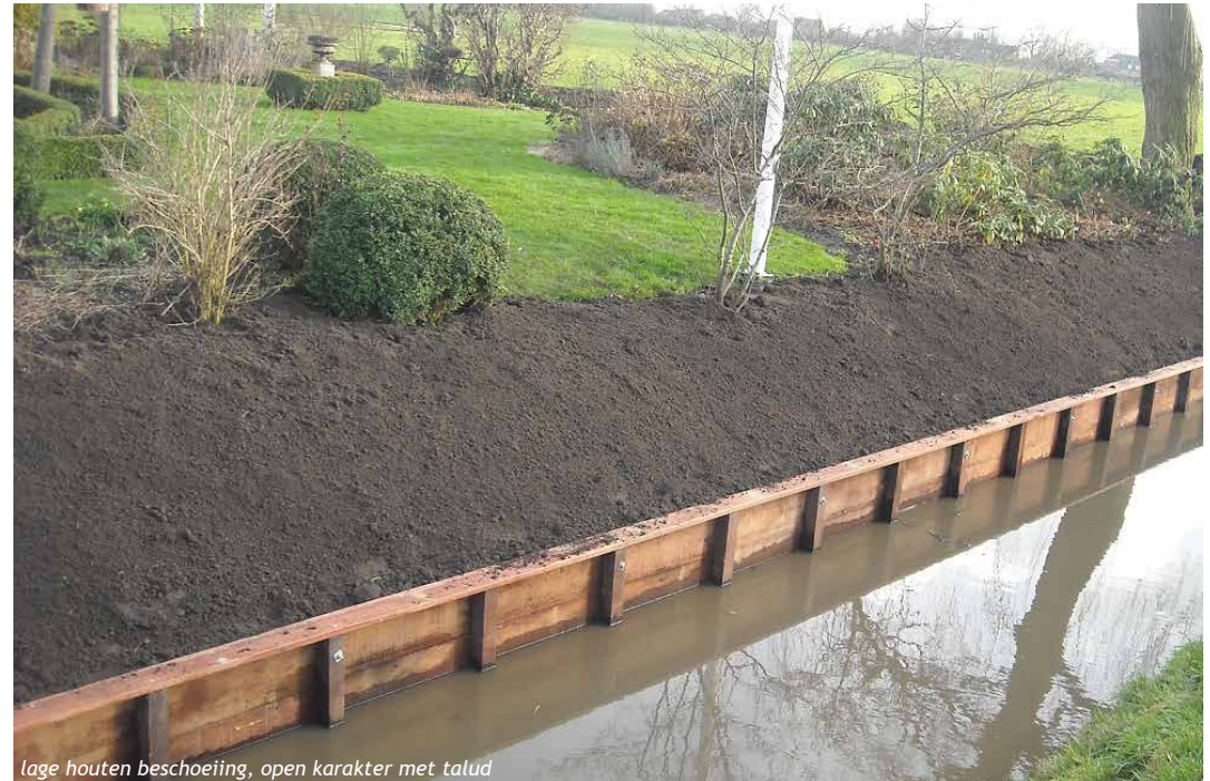
lage houten beschoeiing, open karakter met talud
