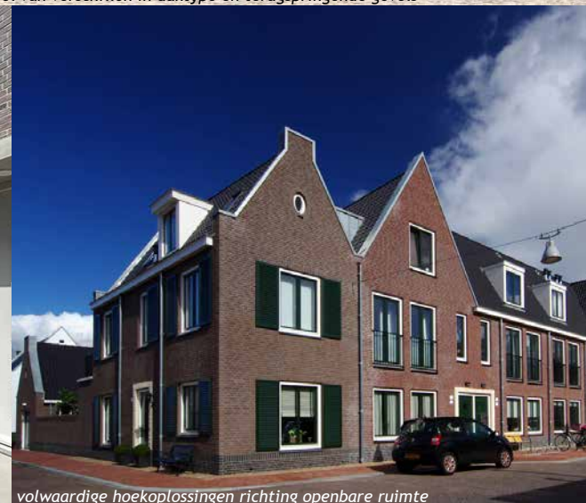
volwaardige hoekoplossingen richting openbare ruimte
