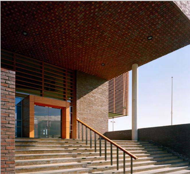
goed zichtbare entree's
