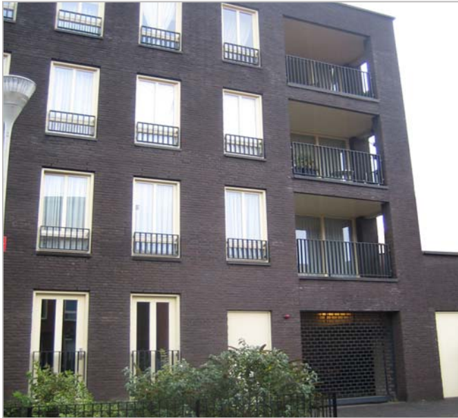
entree parkeergarage geïntegreerd in gebouw
