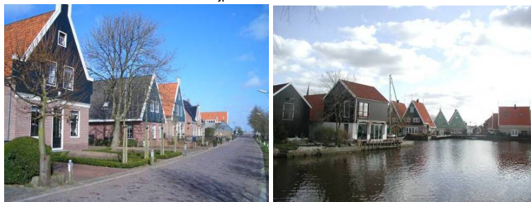
Historiserende bouw in Noordeinde en West-Graftdijk
