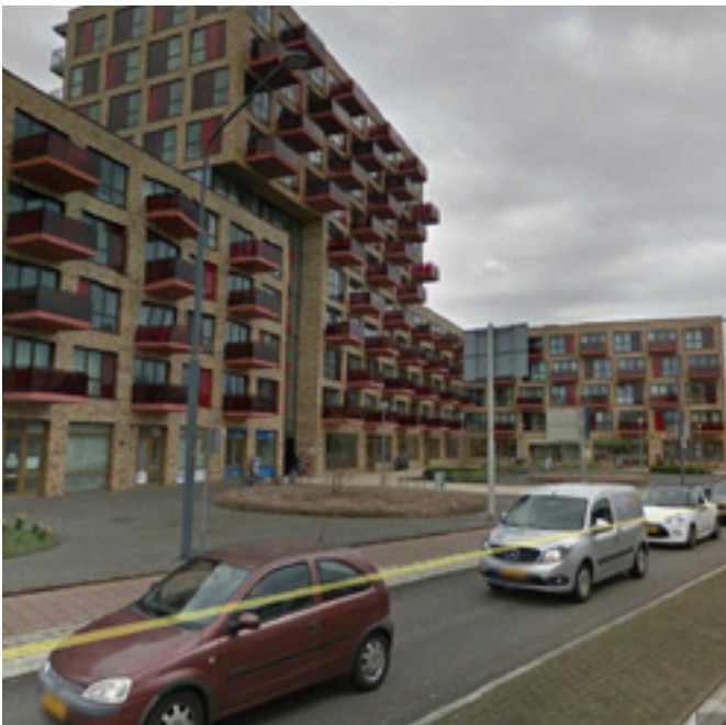
Koelmalaan t.p.v. Geert Groteplein: gemêleerd en met kleur
