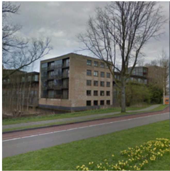
nieuwbouw Tuinderspad: combinatie van kleuren
