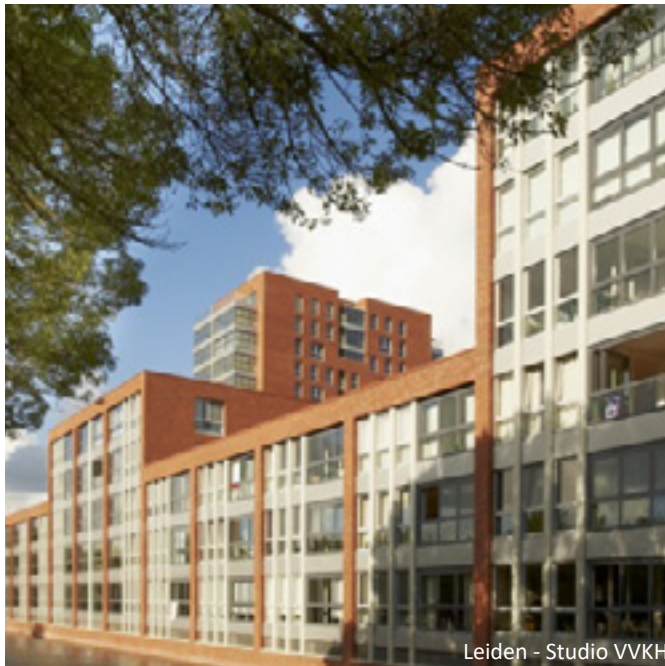
Leiden - Studio VVKH serres in combinatie met het basismateriaal
