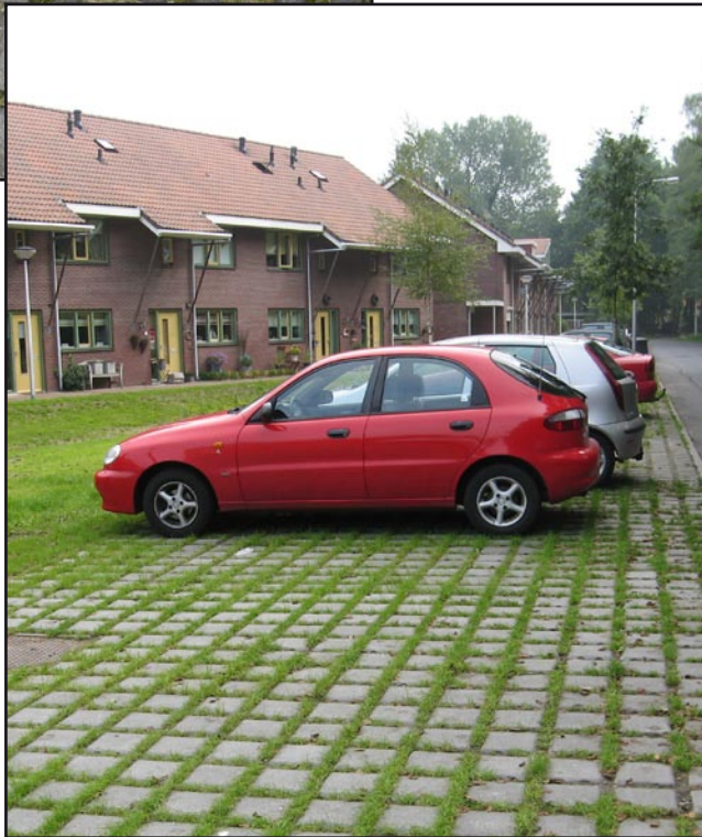
Voorbeeld van halfverharding
