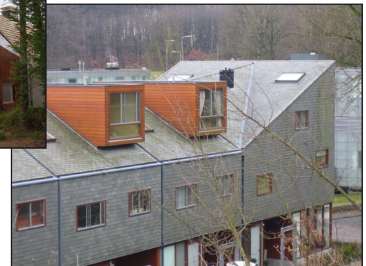
Voorbeeld hoekaccenten in vormgeving en materiaalgebruik
