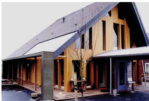
Voorbeeld ingepaste, zonnecollector
