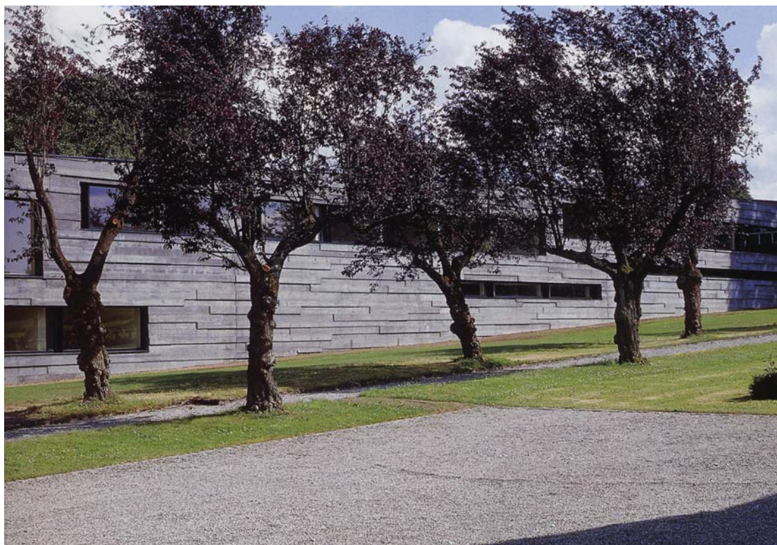
Voorbeeld materialisering met de uitstraling van hout. Beton met structuur van houten bekisting.
