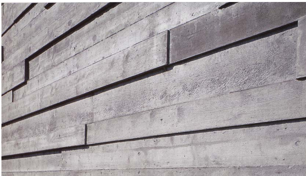
Voorbeeld materialisering met de uitstraling van hout. Beton met structuur van houten bekisting.
