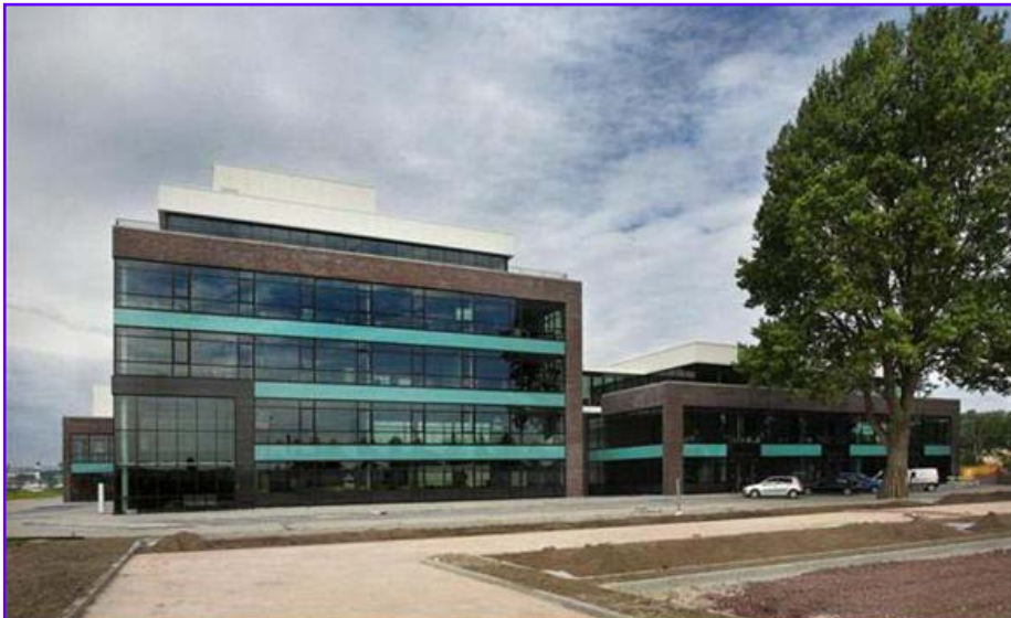
Representatieve gevel aan de Nieuwe Schermerweg
