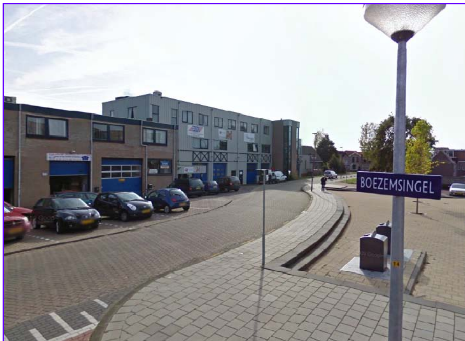
Dijk zichtbaar gemaakt
